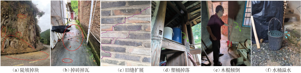
图 6 福建尤溪 3.5 级地震 V 度区典型震害特征
