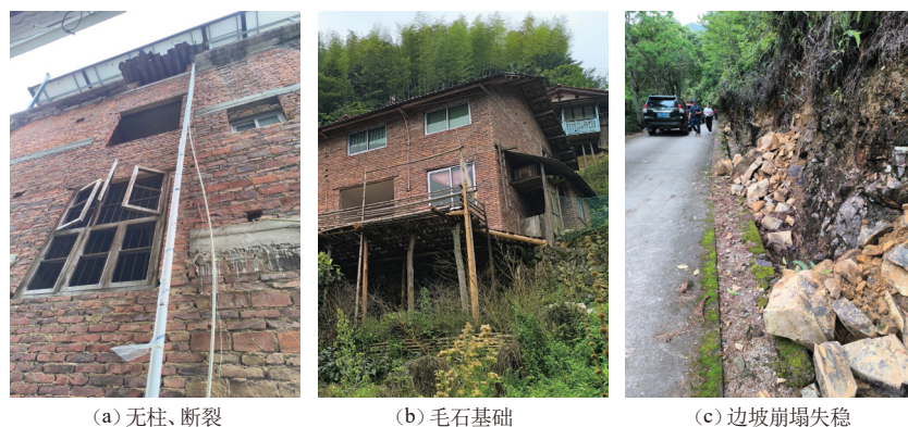
图 7 震区房屋抗震薄弱环节与地质灾害隐患
