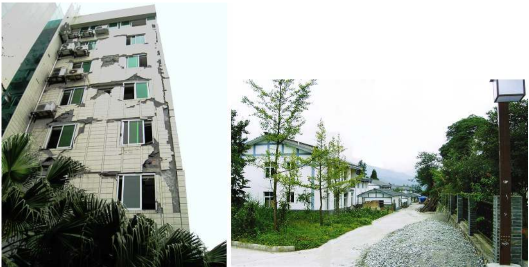
图19 正规建筑经住了汶川大地震的破坏(左图北川,右图成都)
